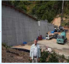
右:対策・復旧状況(以下同じ)
